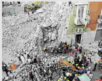
IL CROLLO La palazzina di via Roma
