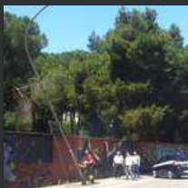
Illuminazione pubblica, ing. Gatta: "150 pali pericolanti, rimuoverli subito"
