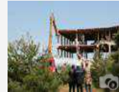
L'abbattimento del mostro di cemento
